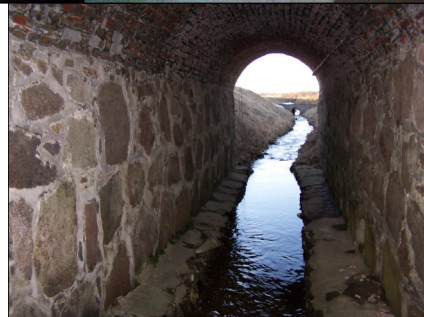
Abb.3: Brücke bei Friedland über die B 197
