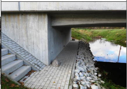
Abb.7 Nicht zu vergessen die platzierten Feldsteine, welche sich auf jeder Seite der Brücke im Eingangsbereich befinden und dem Otter somit einen Markierungsplatz anbieten und insbesondere bei Hochwasser sehr entscheidend für eine Fixierung des Otter unter Brücke sind. Dadurch, dass die Feldsteine sich bereits unter der Brücke befinden markiert der Otter auf diese sein Revier und wandert nicht über den Brückenkörper. Welches sich nach dieser Aufnahme des Fotos am 07.11.2023 auch schon bald bestätigen sollte.
