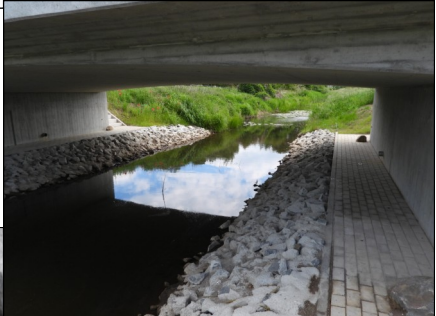
Abb.6: Eine Schutzmaßnahme die für den Otter und andere Semiaquaten sehr gut zu nutzen ist. Einerseits die Steinpackungen die hier schon ermöglichen gefahrlos diesen Bereich zu unterwandern. Zum anderen die gepflasterte Unterführung die neben dem Otter auch Ingenieuren es ermöglichen den Zustand der Brückenwiederlager zu überprüfen. (Foto: 07.06.2022)
